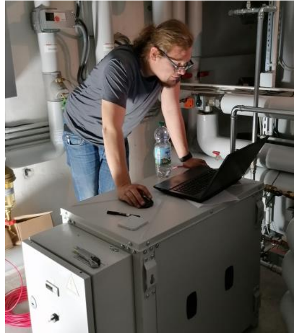
Im April 2020 wurden die letzten Installationsarbeiten der eXergiemaschine – die elektrische Verdrahtung – in dem Augsburger Wohngebäude durchgeführt. (Bild: varmeco)
