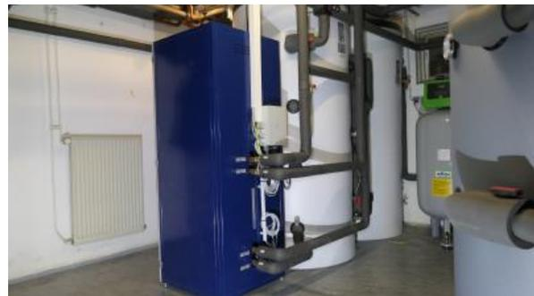
Schlanke Bauform, starke Wirkung: Die eXergiemaschine (blaues Gerät) hebt das Temperaturniveau so an, dass mit der Abwärme der Kältetechnik sogar Reinigungswasser bereitet werden kann. (Bild: varmeco)
