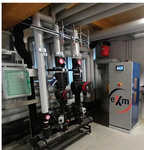
Die Virngrundbäcker GmbH bedient 20 Filialen mit Backwaren. Im Jahre 2023 baute das Unternehmen einen neuen Backbetrieb in Ellwangen mit optimierter Wärmetechnik um den Erdgaseinsatz zu senken. Dabei stand die Rückgewinnung von Abwärme im Mittelpunkt.
