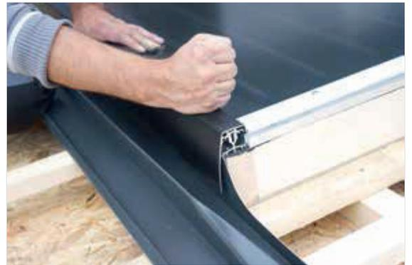
13. Transportleiste als zusätzliche Lattung unter die obere Blecheinfassung mit einem Abstand von 260 mm von Oberkante Kollektor verschrauben. Bei unterschiedlichen Höhen der Lattung ggf. entsprechend anpassen.
