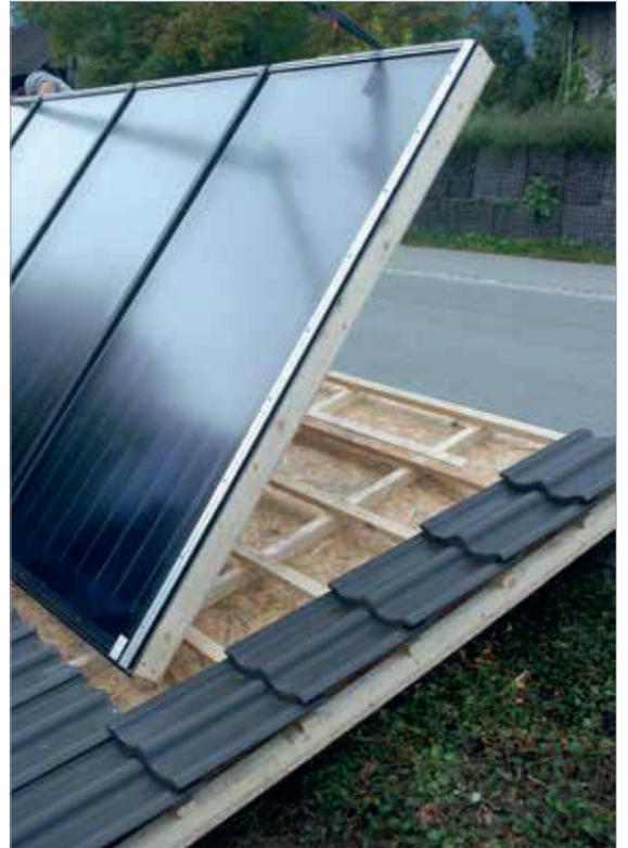
5. Untere Haltewinkel mit Kollektor verschrauben (Spax 5 x 40; 2.2).
