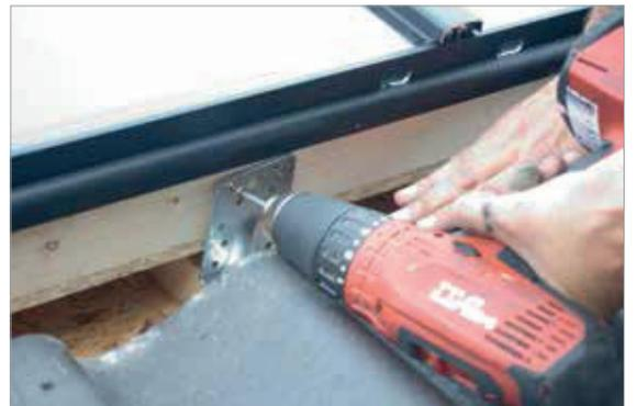
6. Kollektor seitlich an der Dachlattung mit Spax 5 x 80 mm (2.1) verschrauben.
