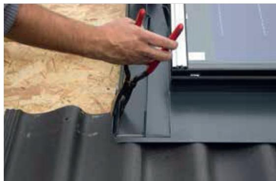
10. Dachpappennägel (7.1) unten und oben in den Kollektorrahmen nageln (ca. 2 cm unter der Glasleiste).
