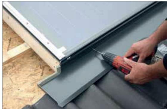
8. Seitliche Blecheinfassung (4.1) einlegen und in den Falz der unteren Einfassung einhängen.
