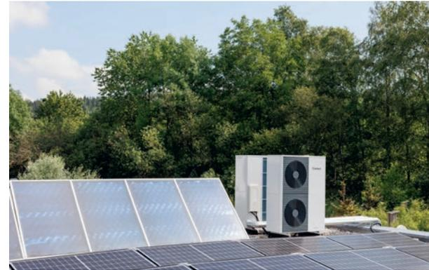
Die beiden Wärmepumpen arbeiten effizient bei ca. 35 °C Heiztemperatur. Für die hygienische Warmwasserbereitung sorgt die eXergiemaschine (eXm), die die erforderlichen 60 °C liefert.
