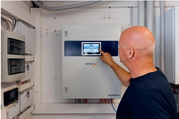
Wolfgang Krebs hat an der Regelung oder am Smartphone volle Kontrolle über sein Heizsystem. Alle Betriebszustände und Wärmeflüsse werden am Regler VarCon380 oder in der Webanwendung VMS (varmeco Management Server) dargestellt.
